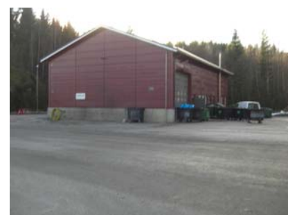
Bilde 3: Vaskehallen der sortering ble utført
